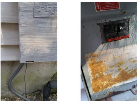
找到墙上类似左图的电箱, 打开, 把里面的开关打到 OFF。
