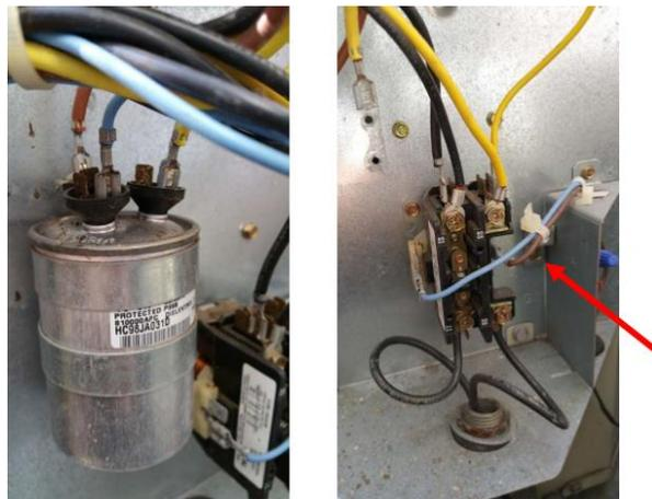
左图: 圆柱形的电容已经微微鼓起来, 说明有问题了。正常的电容顶和底部应该都是平的。右图: contactor, 仔细听嗒嗒声不是从这里发出来。注意箭头位置(G 字上面螺丝)应该是接地线的。前任安装工人并没有按规范做好, 存在安全隐患, 需要接到电源箱里面的地线。
